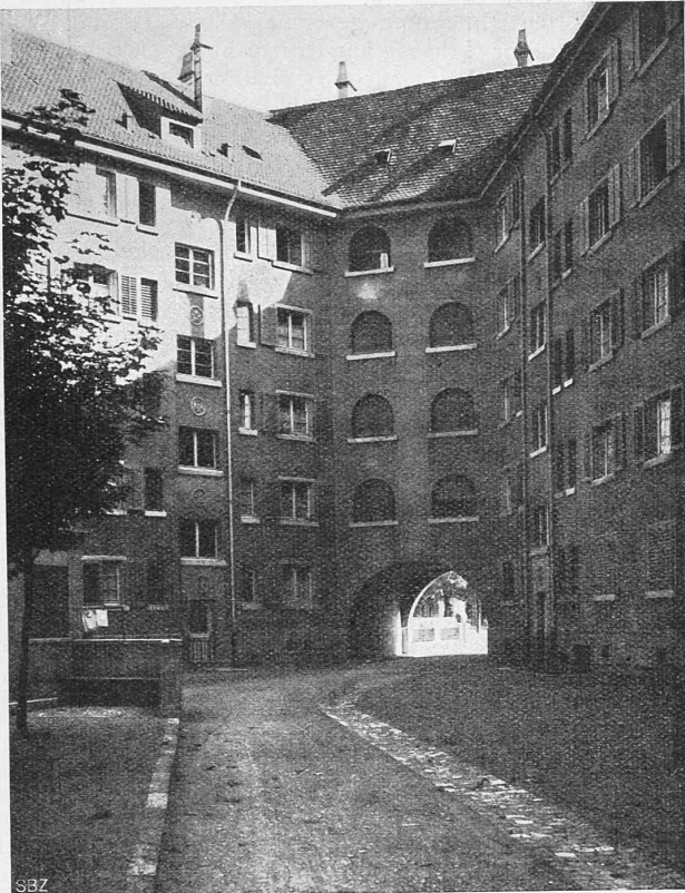
Abb. 6. Blick aus dem Hof gegen die Einfahrt.
