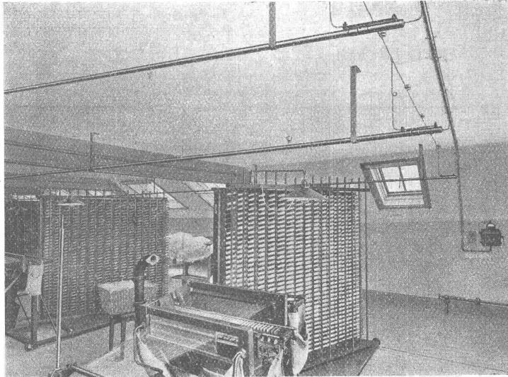
Elektrische Linearheizungen für über 4000 kW Leistung ausgeführt.
