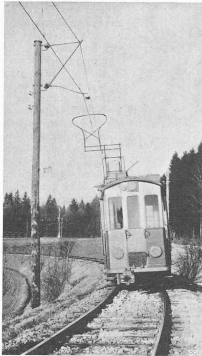
Abb. 2. Fahrleitung der Uetlibergbahn.
