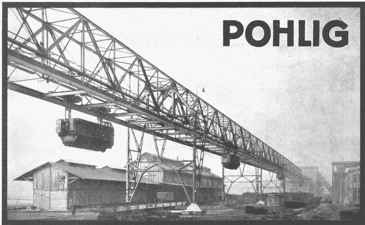
Größte Elektrohängebahnanlage der Welt. Stündliche Leistung 500t. Bild 3: Strecké zwischen Kai und Silo, Länge ca. 400 m
