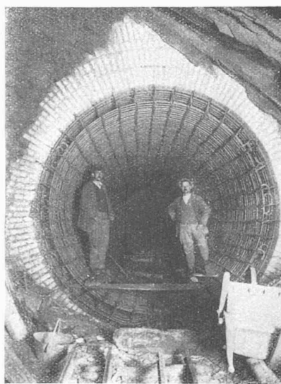
Abb. 40. Doppelarmierung mit Kunststeinring, Versuchstyp VII. (19. VII. 1921.)
