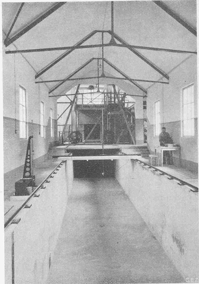
Abb. 3. Innenansicht der Anlage mit Blick in den Messkanal stromaufwärts. Im Vordergrund links der Präzisions-Stechpegel.
