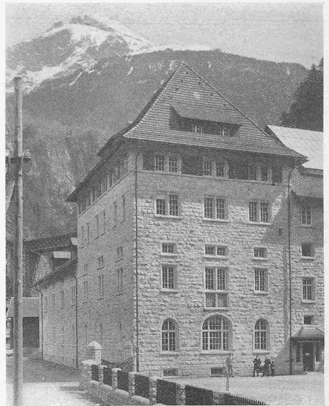
Abb. 74. Das Schaltheaus aus SW, rechts das Schaltstand-Gebäude.
