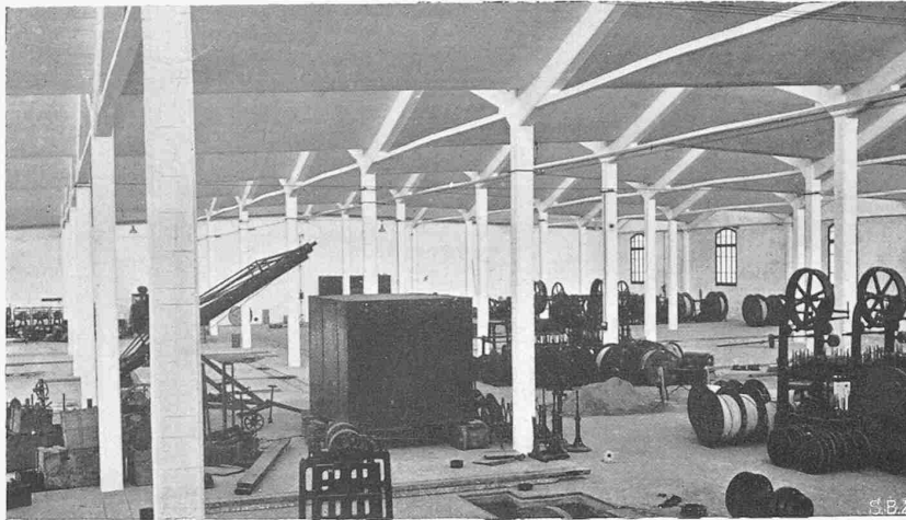
Kabelfabrik von Pirelli in Villa- nueva, Spanien
