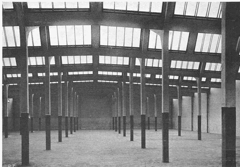
Spinnerei Benet in Barcelona Pfeilerabstand 5 m Keine Zugbänder
