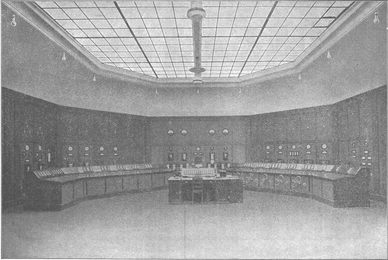
Kommandosaal im Kraftwerk Amsteg.
