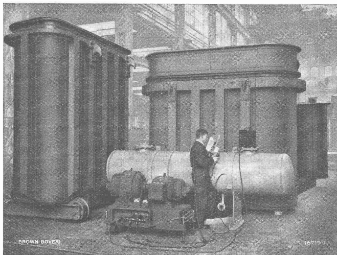
Mit Brown Boveri Lichtbogen-Schweißgruppen elektrisch geschweißte Groß-Transformatorenkessel.
