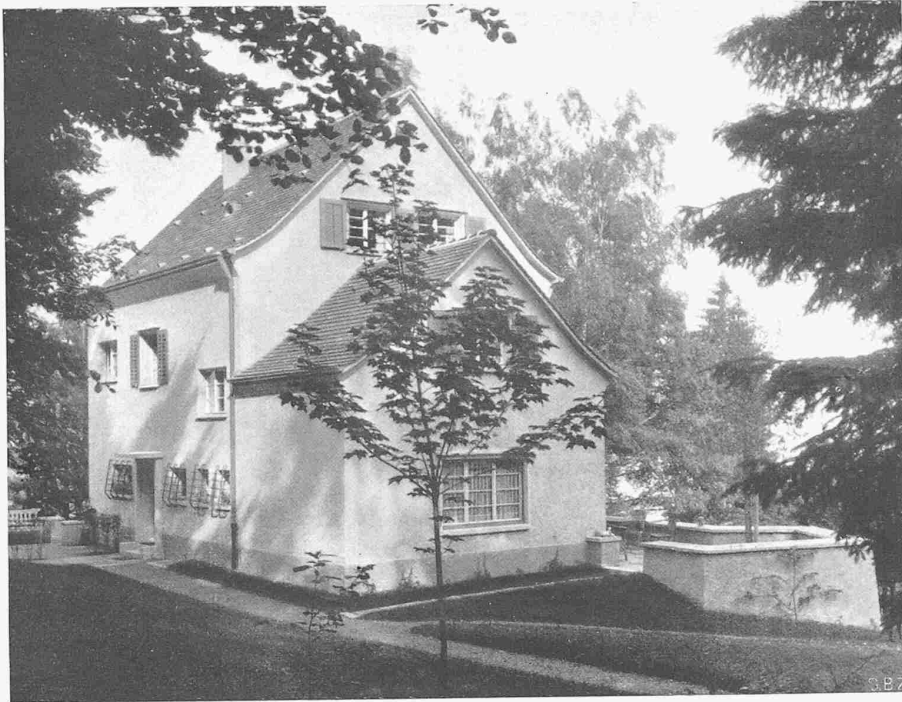
ANSICHT AUS NORDWEST
