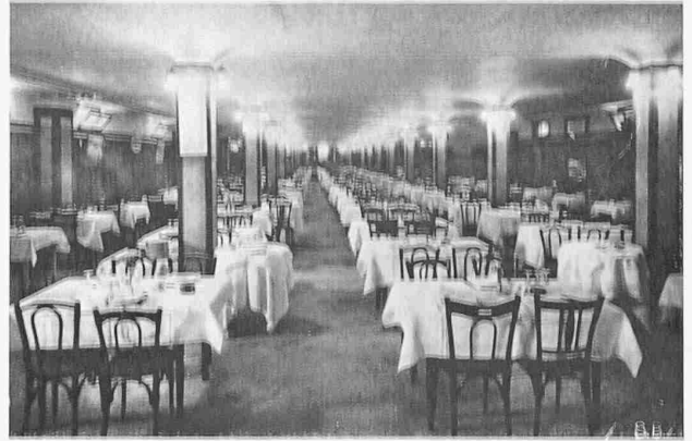
Abb. 6. Provisorisches Restaurant im Kellergeschoss.
