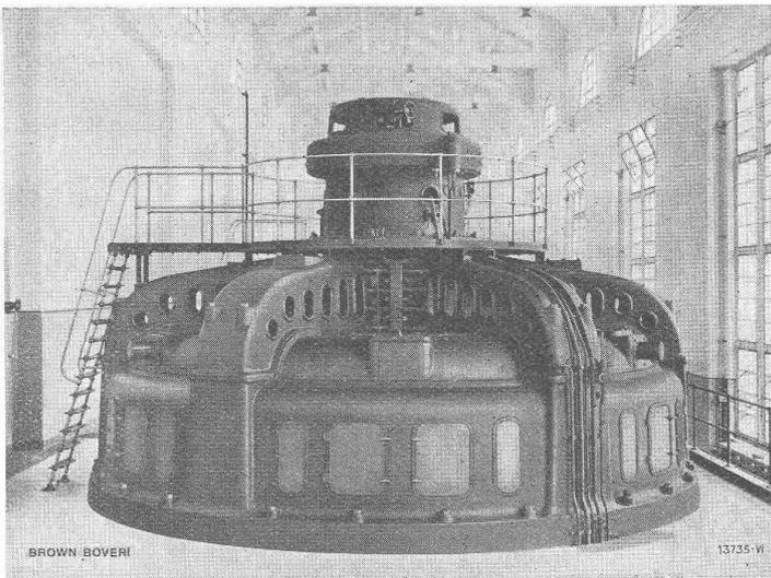
*Hydroelektrische Zentrale Mühleberg an der Aare der Bernischen Kraftwerke A.-G., Bern. Einer der gelieferten sechs Dreiphasen-Wechselstrom-Generatoren von je 8000 kVA, 16000/17600 V, Frequenz 40/50, Drehzahl 133/167.*
