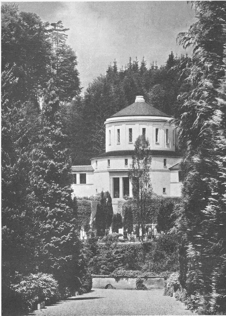
DAS KREMATORIUM IM FRIEDENTHAL, LUZERN VOM MITTELGANG DES FRIEDHOFS GESEHEN ARCHITEKT ALBERT FROELICH, ZÜRICH
