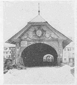
Abb. 3. Portal der alten Brücke.
