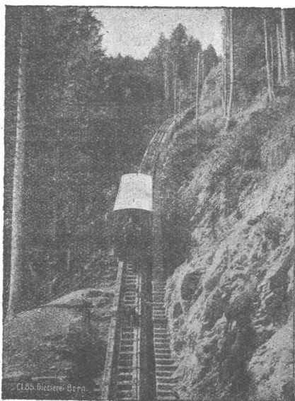
Seilbahn Niesen, I. Sektion, maximale Steigung 66 %.
