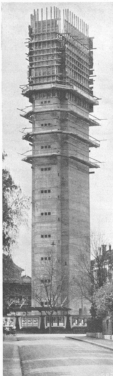
Abb. 14. Gerüstung zum Turmbau.
