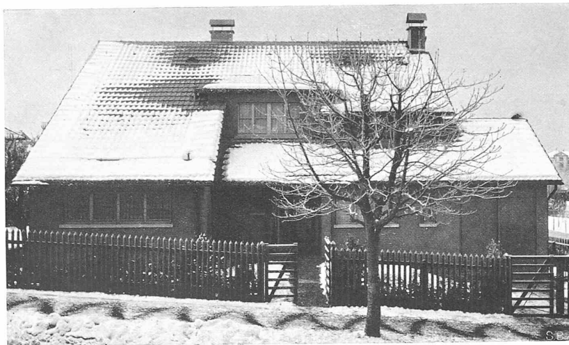
NORDSEITE, MIT EINGANG VON DER KRÄHBÜHLSTRASSE
