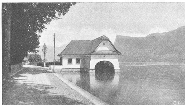
Abb. 6. Boothaus mit Blick gegen den Bürgenstock.
