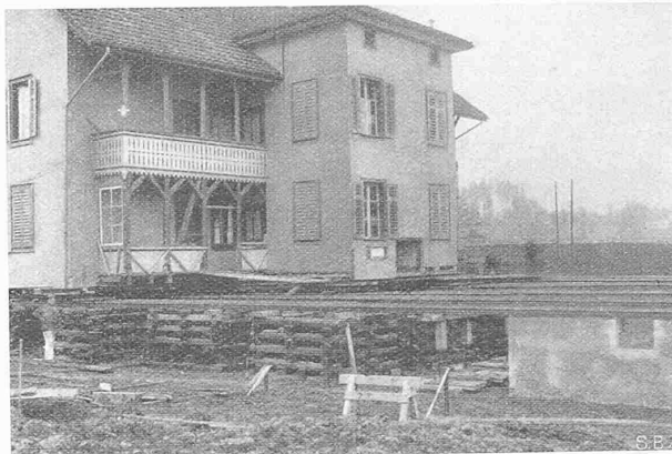
Abb. 9 und 10. Wohnhaus in Perlen: in bewohntem Zustand um 62 m verschoben durch Zimmermeister Heinr. Näf in Speicher.
