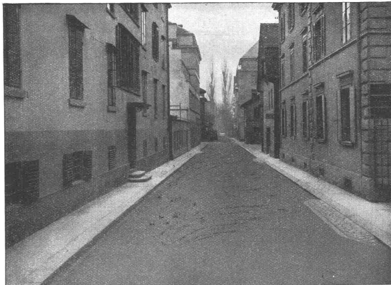
GLARNISCHSTRASSE ZÜRICH Walz-Asphalt: Topeka, 6 cm stark
