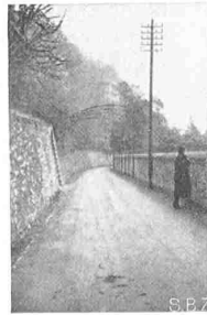
Abb. 11. Str. Circolare unterhalb Grieder.
