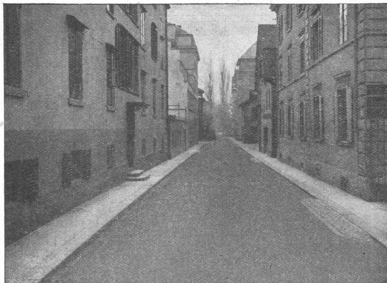
GLÄRNISCHSTRASSE ZÜRICH Walz-Asphalt: Topeka, 6 cm stark
