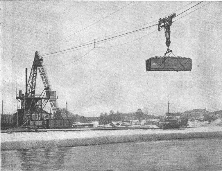
Kabelkran zum Transport von Torf über einen Fluss.
