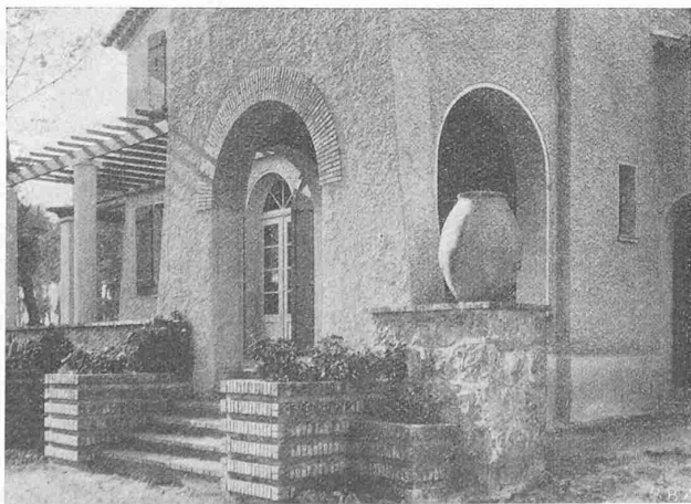
Abb. 9. Haupteingang an der Südostfront des Hauses F.
