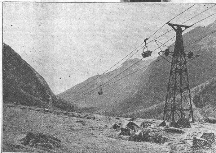
Drahtseilbahn für die Zuführung von Bau- material zum Bau der Grimseltalsperre.
