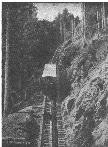
Seilbahn Niesen, I. Sektion, maximale Steigung 66 ‰.
