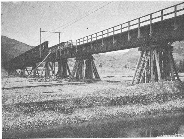
Abb. 10. Die 1927 erstellte Hilfsbrücke, gegen Buchs gesehen.
