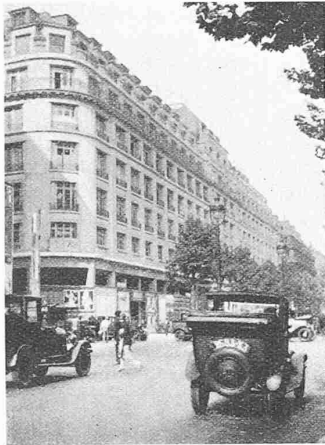
Abb. 7. Neues Geschäftshaus am Boulevard Hausmann in Paris.
