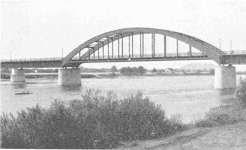
Abb. 5. Eiserne Strassenbrücke über die Donau in Deggendorf, Stützweite 87 m.
