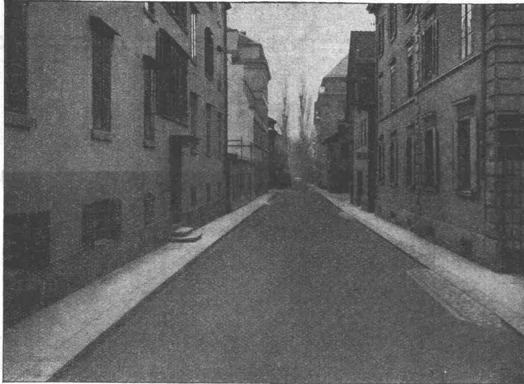
GLARNISCHSTRASSE ZÜRICH Walz-Asphalt: Topeka, 6 cm stark
