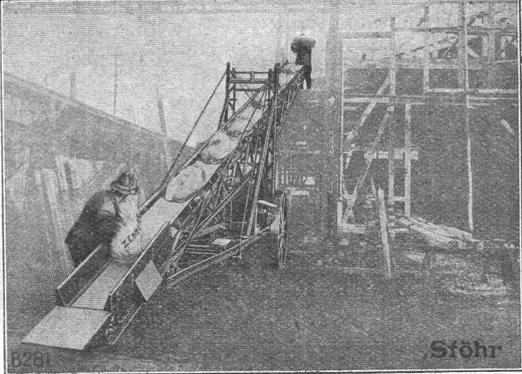
zum Fördern und Aufsichten von Zement in Säcken, Sand, Beton-
