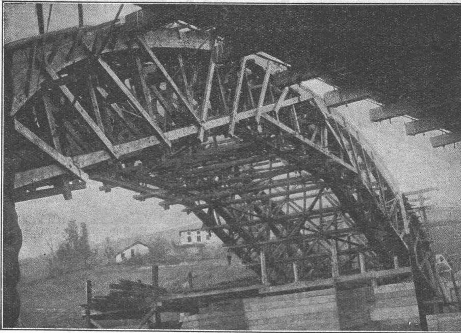
Lehrgerüst Pont d' Itxassou - 69,00 m Spannweite
