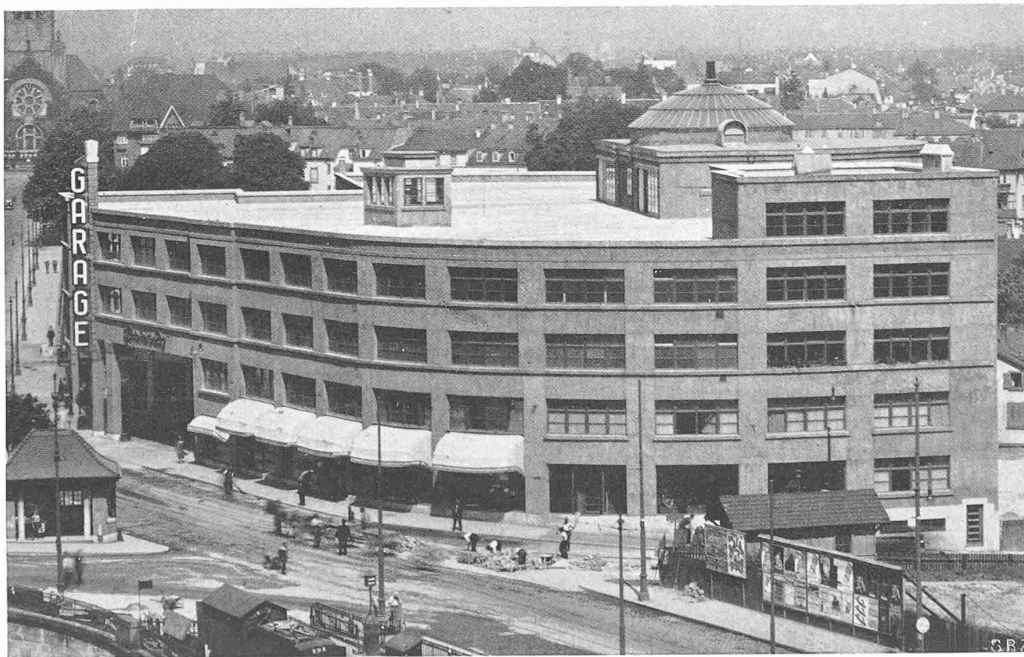
Abb. 8. GESAMTBILD VOM BÄHNHOF, MIT DER DACHTERRASSE GROSSGARAGE C. SCHLOTTERBECK, BASEL ARCHITEKTEN W. E. BAUMGARTNER & H. HINDERMANN, BASEL
