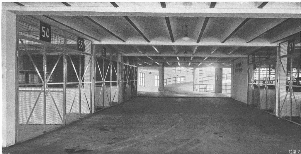
Abb. 11. VERSCHLISSBARE BOXEN MIT DRAHTGEFLECHT-EINWANDUNG
