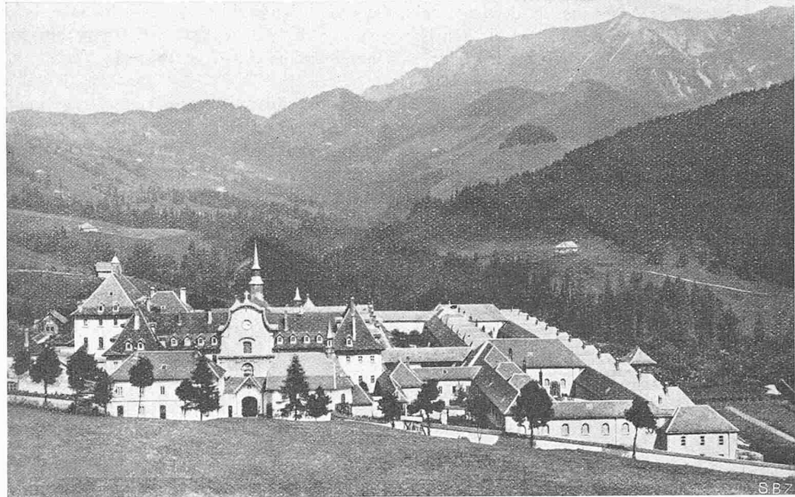
Le monastère des Chartreux de la Valsainte, visité lors de l'assemblée de la S. I. A. Porche de l'entrée et façade ouest de l'église, à droite les trois rangées d'ermitages.
