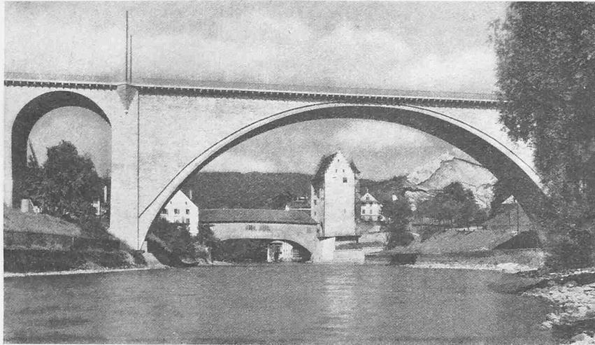
Abb. 1. Eisenbeton-Bogenbrücke Baden-Wettingen über die Limmat. — Ansicht talabwärts.
