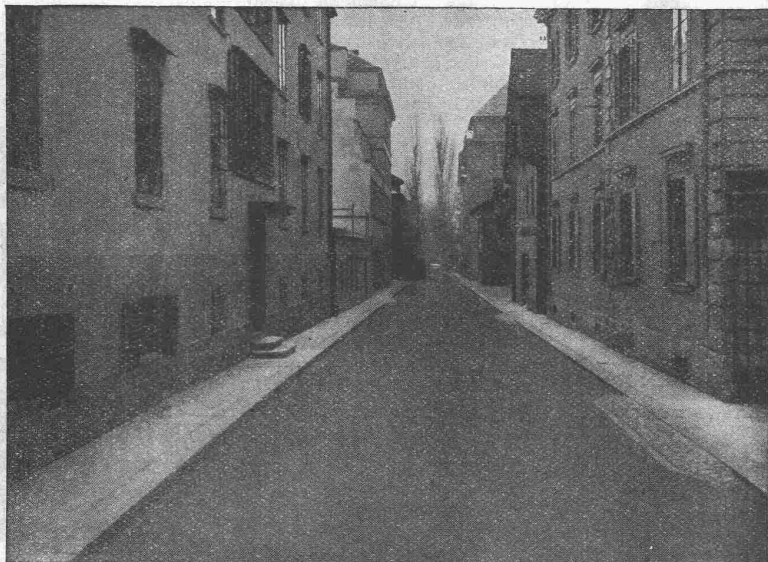
GLÄRNISCHSTRASSE ZÜRICH Walz-Asphalt: Topeka, 6 cm stark
