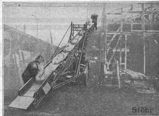
zum Fördern und Aufsichten von Zement in Säcken, Sand, Betonmisch, Kohle usw. Zum Ausschachten von Baugruben und zum Be- und Entladen von Wagen aller Art.
