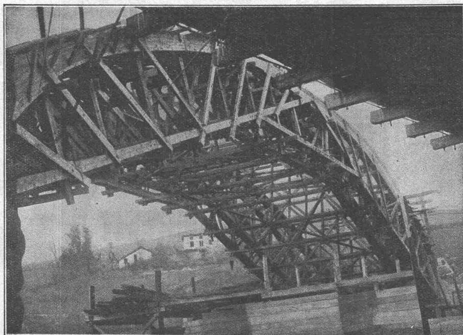
Lehrgerüst Pont d' Itxassou - 69,00 m Spannweite
