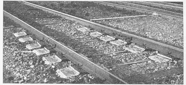
Abb. 1. Eisenbeton-Schwellen System Emperger.
