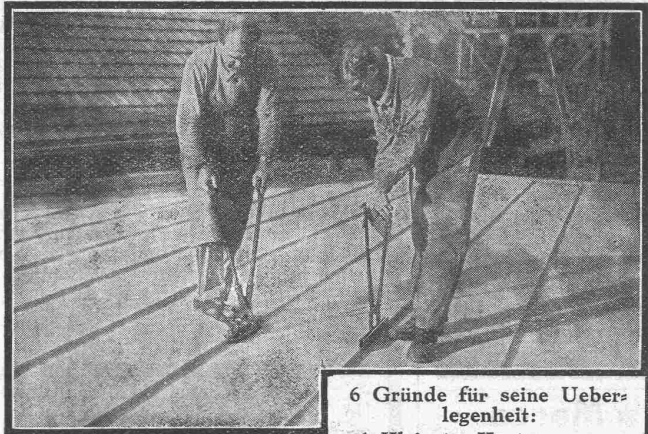
Eindeckung mit Armco-Baublech des Lagerhauses Julius Schoch & Co., Zürich
