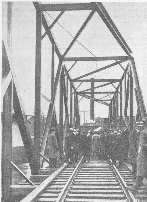
Abb. 7. Einblick in die fertige Brücke.
