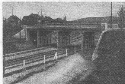
Römerstrassenbrücke in Winterthur
