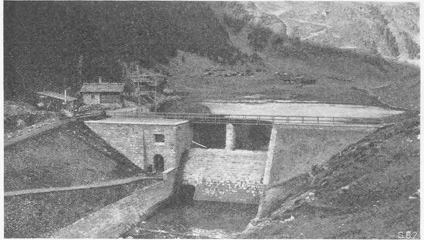
Abb. 77. Stauwehr und Wasserfassung, Unterwasserseite, in fertigem Zustand.
