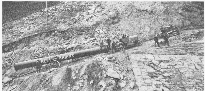
Abb. 78. Rohrtransport auf einer Steigung von 30%.
