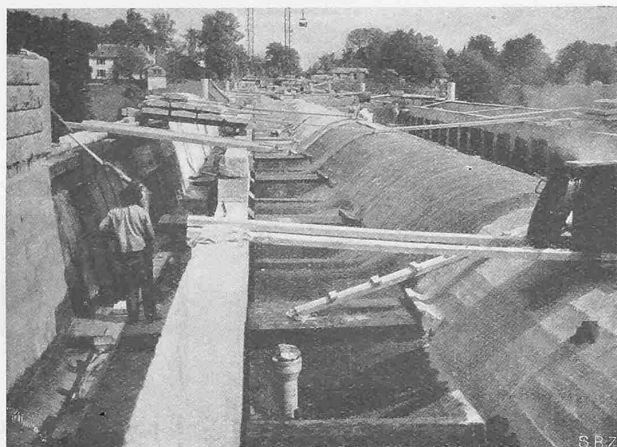
Fig. 23. Voûtes supérieures avant le remplissage.
