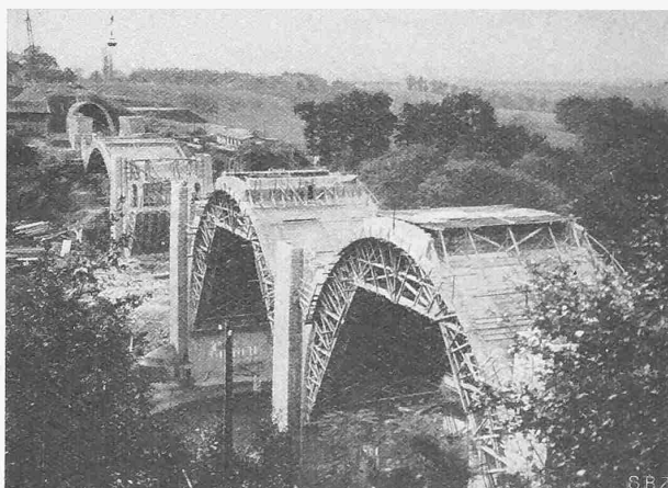
Fig. 15. Exécution des grandes voûtes. 19 octobre 1924.
