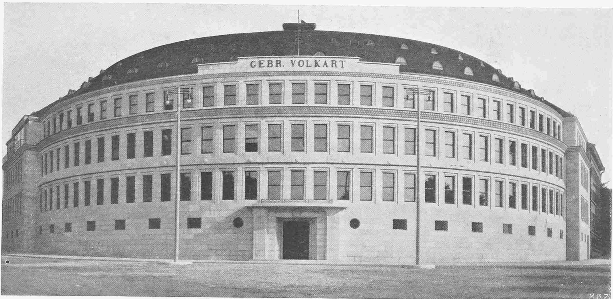
GESCHÄFTSHAUS DER FIRMA GEBRÜDER VOLKART IN WINTERTHUR ARCHITEKTEN RITTMAYER & FURRER, WINTERTHUR
