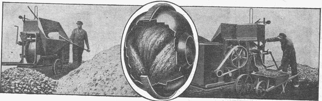
**Für Fr. 1790.-** erhalten Sie den weltbekannten fahrbaren **FRIMO-MISCHER**, 150 Liter Trommel-füllung mit unzerstörbarer S. M. Stahltrommel **inklusive 3 PS Benzinmotor**, für deren Güte tausende von betriebssicheren Anlagen Ihnen die beste Garantie geben. Auf Wunsch unverbindliche kostenlose Vorführung auf **Ihrem** Bauplatz.
