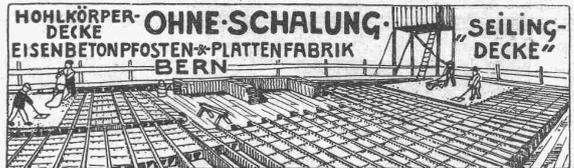
HOHLKÖRPER-DECKE OHNE SCHALUNG SEILING-DECKE
