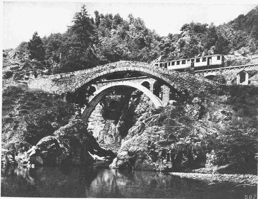
Abb. 11. GEWÖLBTE BRÜCKE ÜBER DIE MELEZZA IM VORDERGRUND ALTE SAUMWEG-BRÜCKE, IM HINTERGRUND DIE TALSTRASSE
