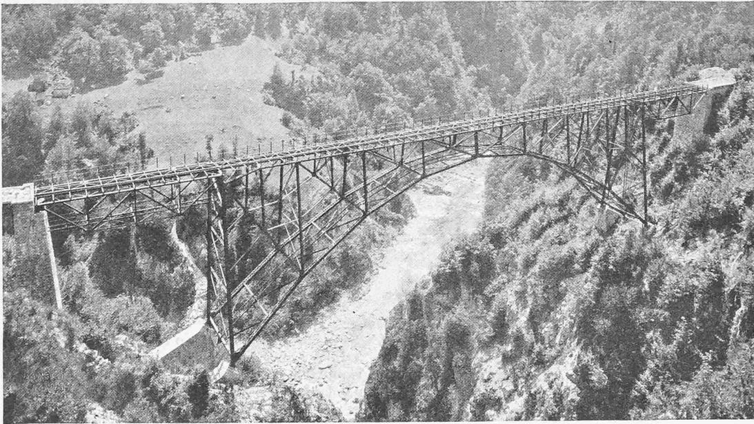
Abb. 8. Ruinacci-Brücke bei Camedo (nach Vollendung der Eisenkonstruktion). Stützweite 65,920 m, Gefälle  $3\text{‰}$ .
