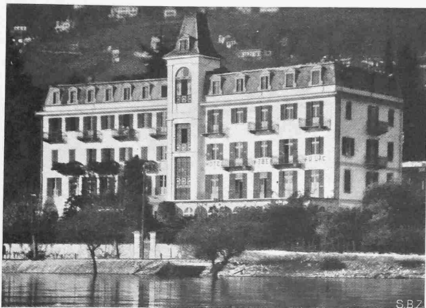
Abb. 4. Hotel Reber in Locarno im frühern Zustand.
