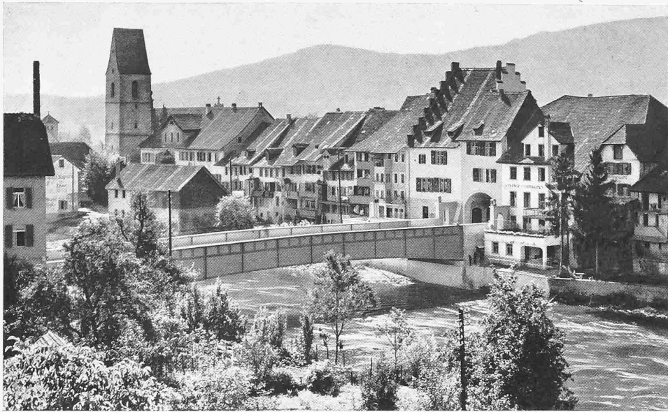
DIE NEUE EISERNE REUSSBRÜCKE IN MELLINGEN BLICK VOM RECHTEN UFER, FLUSSAUFWÄRTS
